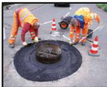
Zakładamy taśmę EUROKAN-Fugenband.
