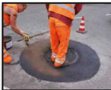
Wykonujemy posypkę z bitumowanego piasku.
