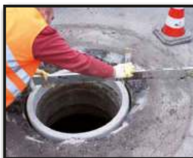
Fachowo wykonujemy podbudowę wraz z wbudowaniem pierścienia montażowego.
