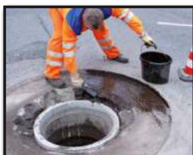
Nakładamy emulsję bitumiczną EUROKAN-Haftkleber.
