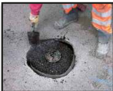
Wykonujemy wierzchnią warstwę nawierzchni mieszanką EUROKAN-MULTIphalt 0/8 lub 0/5.
