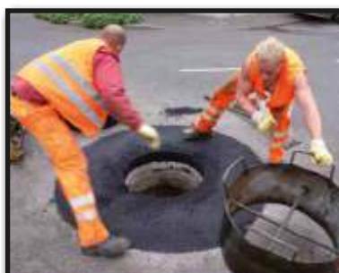
Usuwamy metalowy szalunek umożliwiający wbudowanie asfaltu.
