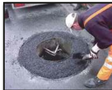
Nakładamy wierzchnią warstwę asfaltu.
