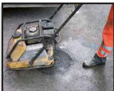
Zagęszczamy ostatecznie nawierzchnię asfaltową.
