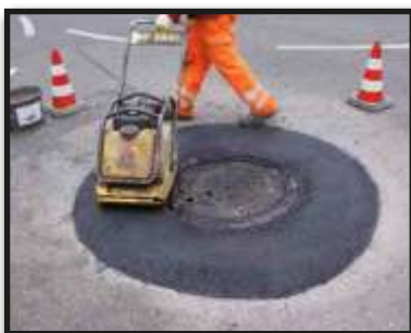
Poprzez wibrowanie dociskamy samopoziomujący się właz kanałowy i ostatecznie zagęszczamy asfalt.
