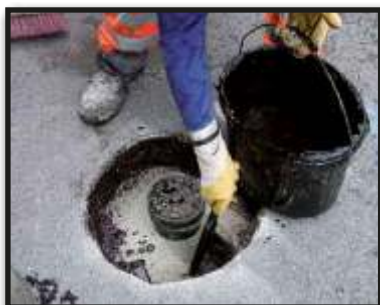
Nakładamy emulsję bitumiczną EUROKAN-Haftkleber.
