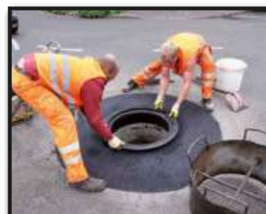
Osadzamy samopoziomujący się właz kanałowy.
