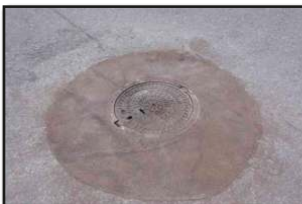
Usuwamy metalowy szalunek umożliwiający wbudowanie asfaltu.
