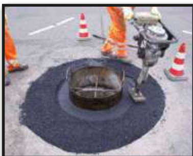
Wstępnie zagęszczamy asfalt.
