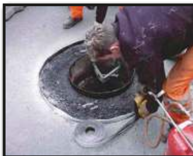
Zakładamy taśmę EUROKAN-Fugenband w celu perfekcyjnego uszczelnienia spoin.
