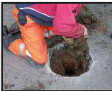
Wyciągamy uszkodzoną skrzynkę i oczyszczamy boczne powierzchnie wykopu.
