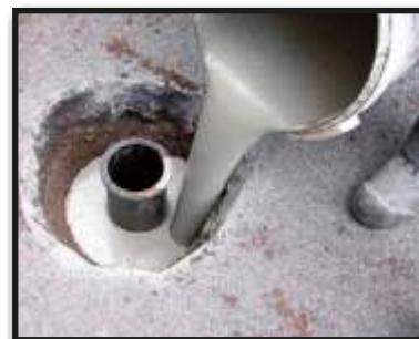
Nową, odpowiednio osadzoną skrzynkę zalewamy trwale zaprawą HEVOLIT-FIX 3K
