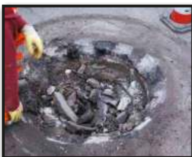
Usuwamy stary właz kanałowy i gruz.
