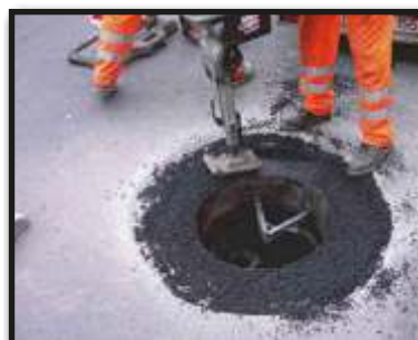
Zagęszczamy warstwę nośną asfaltu.
