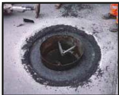
Nakładamy emulsję bitumiczną EUROKAN-Haftkleber poprawiającą przyczepność.
