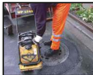
Na końcu zagęszczamy ostatecznie całą konstrukcję.
