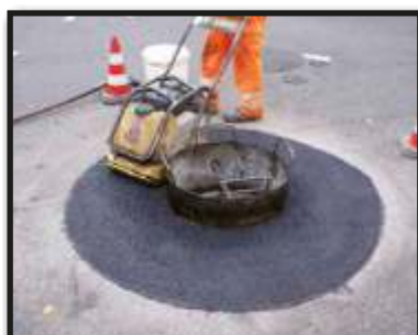
Ponownie zagęszczamy asfalt.
