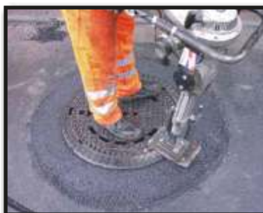
Wbijamy właz kanałowy do świeżego jeszcze asfaltu.
