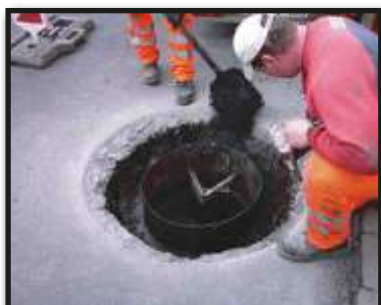
Umieszczamy warstwę nośną asfaltu.
