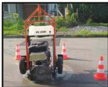
Wycięcie włazu przy pomocy specjalnej piły.
