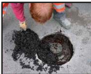
Wykonujemy podbudowę mieszanką EUROKAN-MULTIphalt 0/11 i wstępnie ją zagęszczamy.
