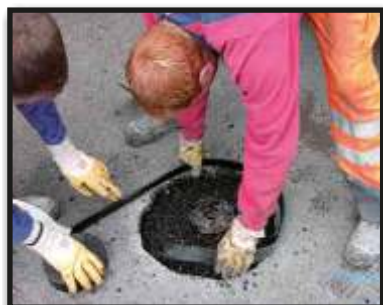
Zakładamy taśmę EUROKAN-Fugenband.
