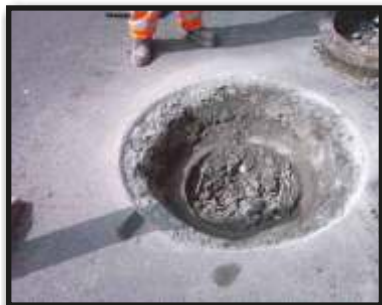
Wyjmujemy uszkodzony właz kanałowy.
