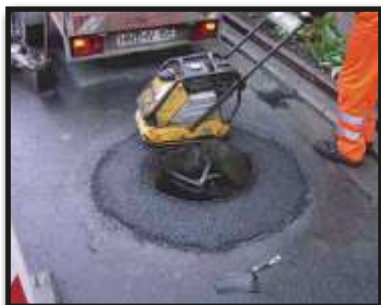
Wstępnie zagęszczamy wierzchnią warstwę asfaltu.
