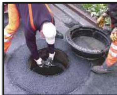
Usuwamy metalowy szalunek.
