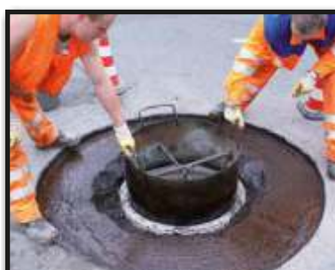
Osadzamy metalowy szalunek w celu wbudowania asfaltu.
