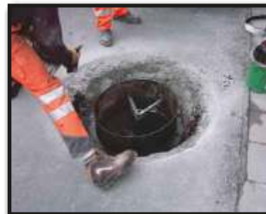
Nakładamy emulsję bitumiczną EUROKAN-Haftkleber poprawiającą przyczepność.
