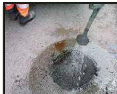
Polewając mieszankę EUROKAN-MULTIphalt wodą przyspieszamy jej twardnienie.
