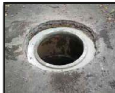
Usunięcie wyciętej warstwy asfaltu.
