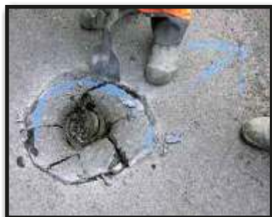
Usuwanie nawierzchnię wokół uszkodzonej skrzynki.
