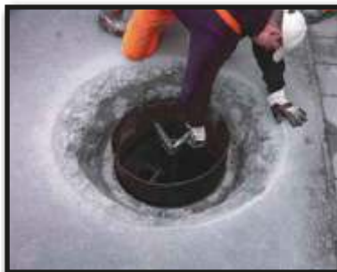
Osadzamy metalowy szalunek w celu wykonania warstwy nośnej z asfaltu.
